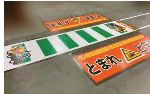
化学メーカーの工場通路に横断歩道表示を施した事例を紹介する。従来の塗装では、生産ラインが止まる日程を選び、丸1日以上かけて行うしかなかった。多色づかいをすればさらに日数がかかる。しかし、今回、DAPSを用いて行うことでの、生産ラインを止めることなく、3時間程度の施工2回で完了させた。施工2回というのは、操業に支障を来さないように、全体の施工場所を半分ずつに分けて行ったのだという。しかも写真でわかるように、多色づかいをして、鮮明に表示している。
