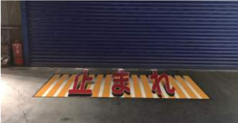
もとは、50cmほどの白線と一旦停止のシートを貼るのみ。効果はなく、停止する運転手がいなかったと聞き、提案・施工。速くからでも目にとまる2色のラインで注意を促し、「ドライバー目線」でデザインした「止まれ」の文字。飛び出すような立体感のある床サインに、施工後はドライバーがきちんと止まるようになったと好評。
